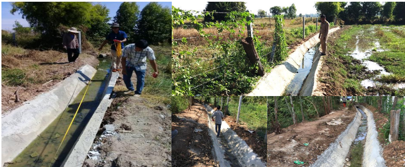
๑. ก่อสร้างเหมืองตาดคอนกรีต หมู่ที่ ๔
